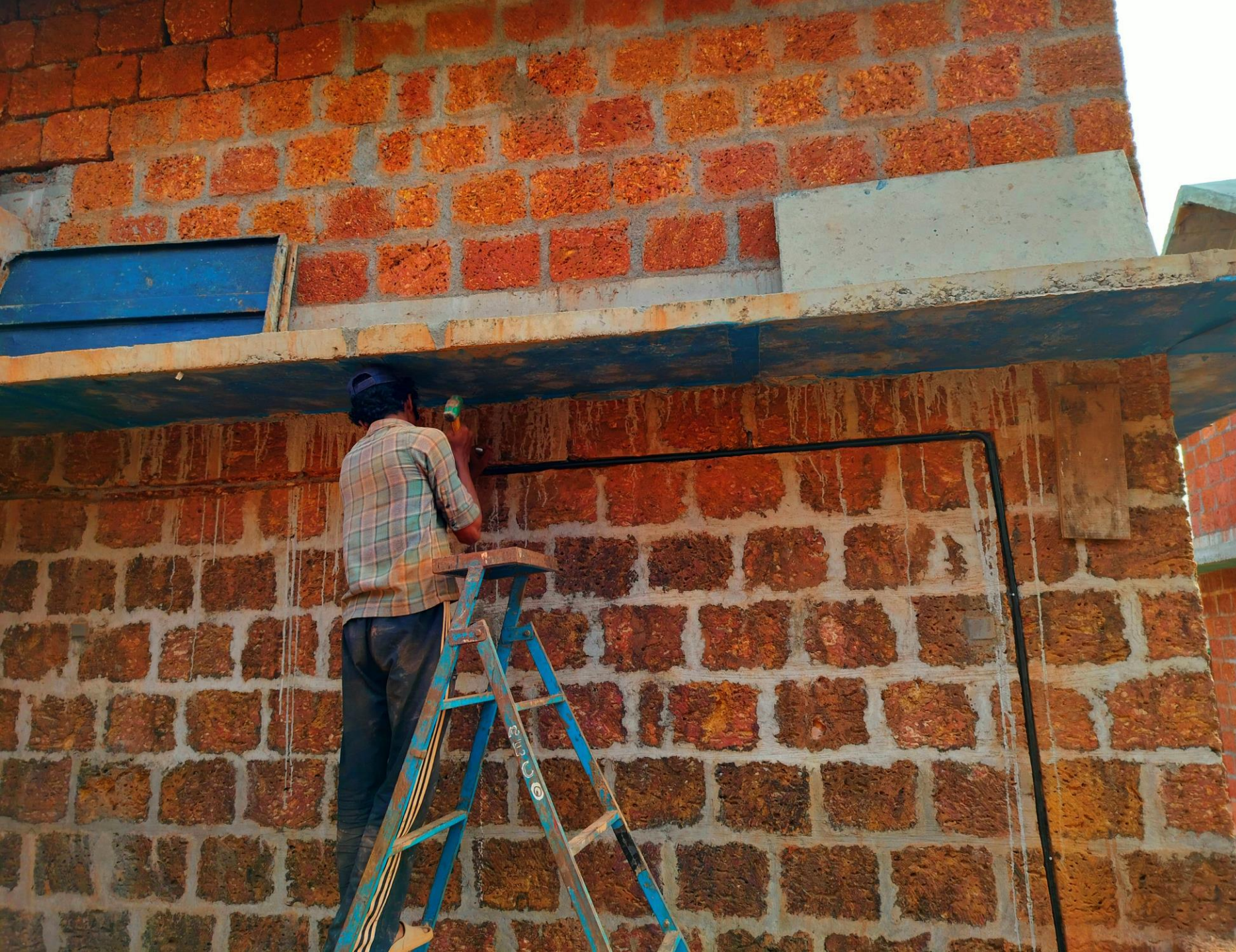
Electrical conduit laying
